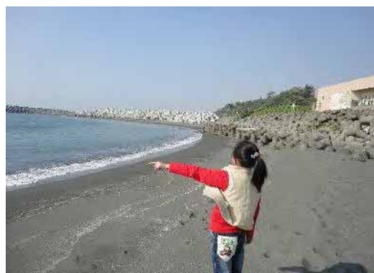
實地探訪旗津海岸-防波堤現場
