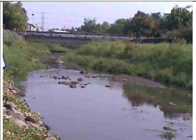
圖 49. 溪洲排水南州民族路橋段
