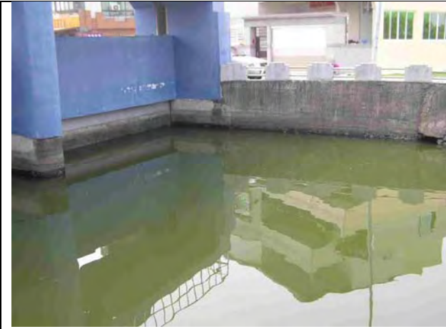
圖 53. 牛埔排水沿海路藍色閘門現況
