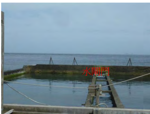
池堤在向海的一邊設有水閘門
