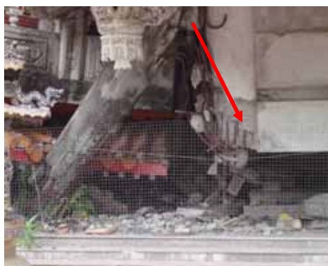
圖 5-9 武昌宮柱子折斷的情形
