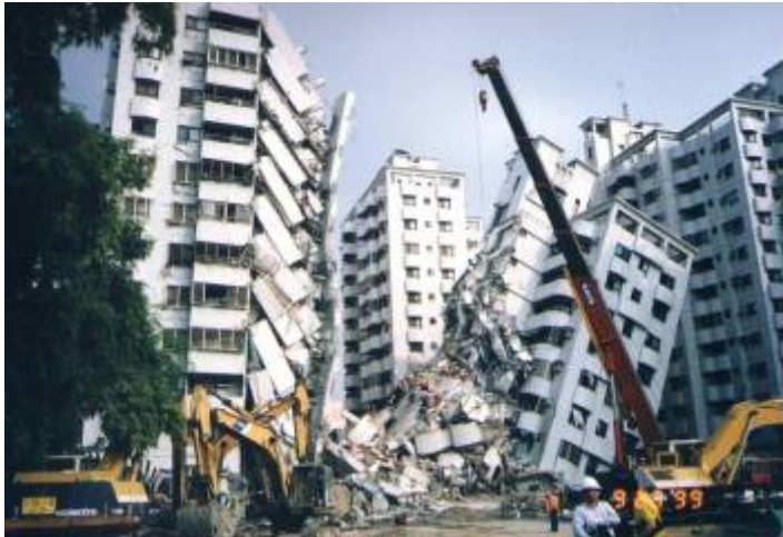
圖 1-1 921 地震破壞情形
