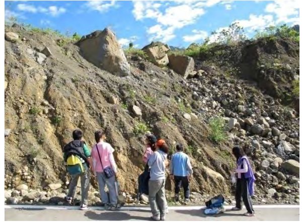
照片 6 舊河道的上面已被獻肚山的落石覆蓋了。
