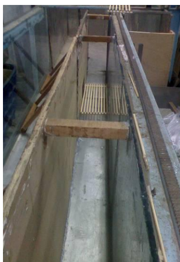
渠槽下半部份往下游面俯視
