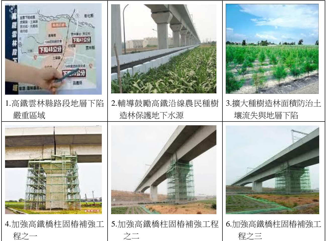
圖 6-1：在高鐵地層下陷嚴重地區植樹造林與加強固樁工程（資料來源：公共工程委員會）
