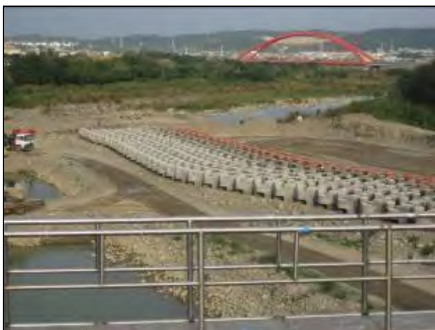
河道上正在進行堤防工程
