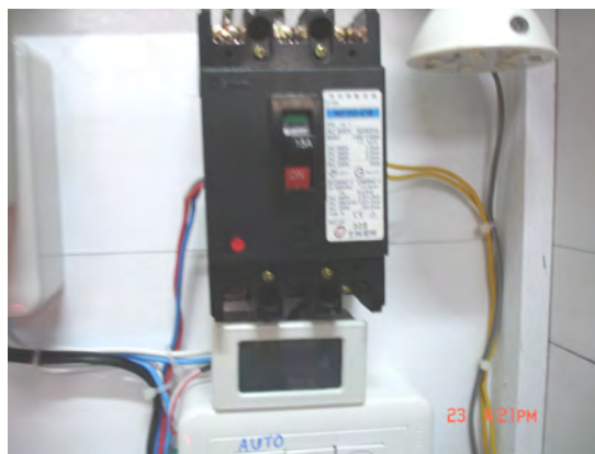
圖 4-49 偵測溫度達 40°C 以上跳電燈熄
