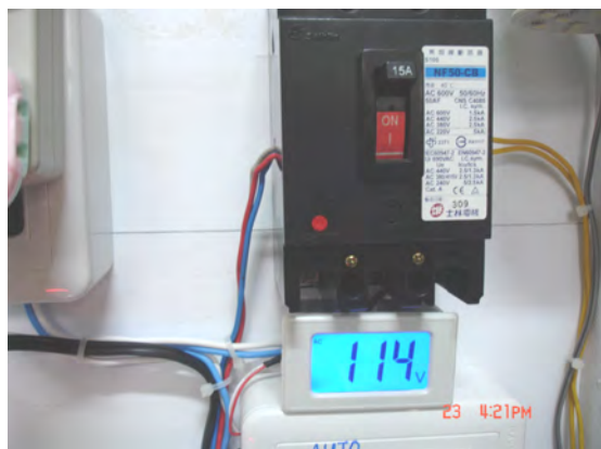
圖 4-48 正常供電且顯示市電
