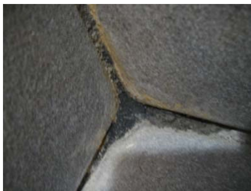
圖十六：廁所角落上的明顯黑處
