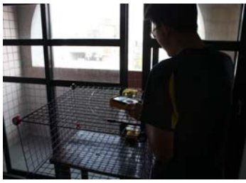
圖 9 在五樓空教室落地窗前裝設發電機組
