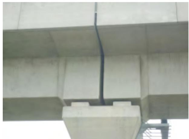
圖五十、 高鐵橋墩接縫
