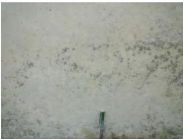
圖四十九、高鐵橋墩下方深灰痕跡（近照）
