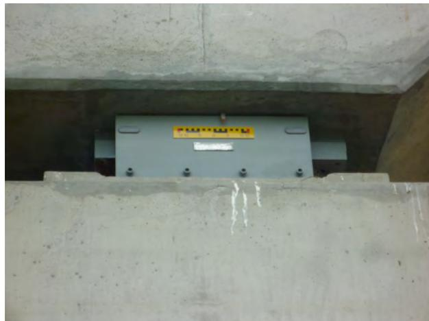
圖五十二、高鐵橋墩的固定性盤式支承
