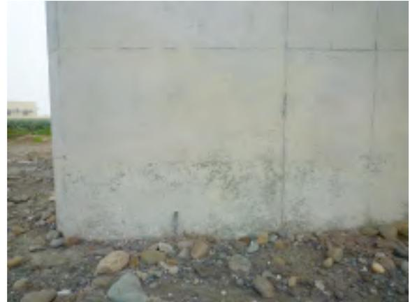
圖四十八、高鐵橋墩下方深灰痕跡
