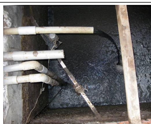
(照片 4-2) 原廢水取自調整池（容量 230 公噸）
