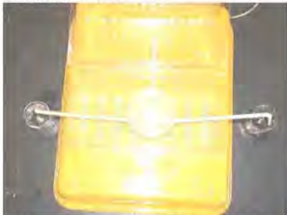
接好槽底的入口管線及兩側分流出水口
