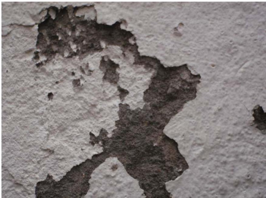
圖18 海砂屋混凝土牆
