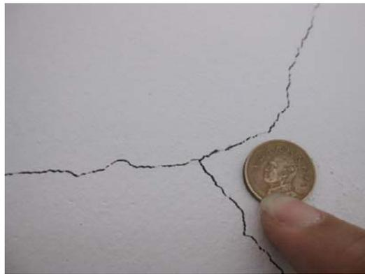
圖13 大裂縫混凝土牆
