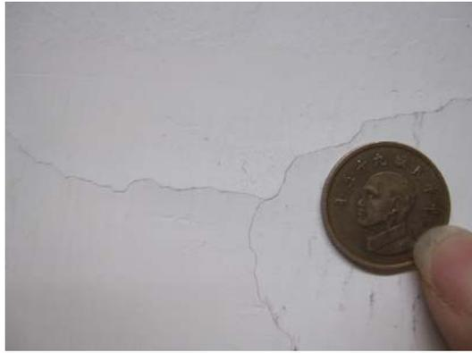
圖12 小裂縫混凝土牆
