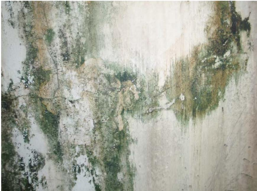
圖17 壁癌混凝土牆
