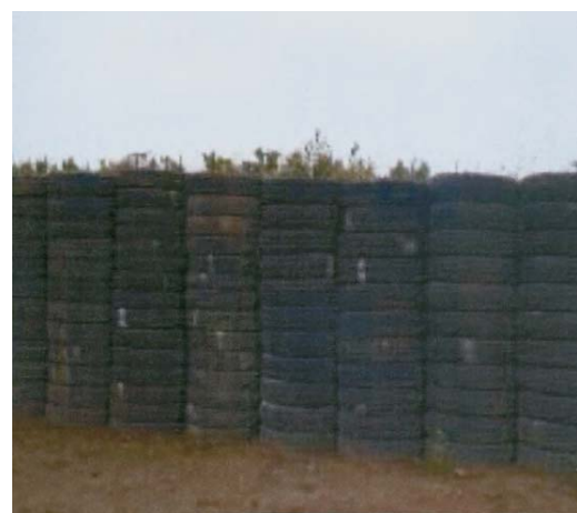
圖 6 廢輪胎擋土牆(新竹市衛生掩埋場)[12]
