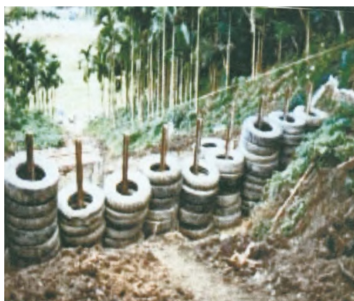
圖 7 鋼軌輪胎壩施工前[6]
