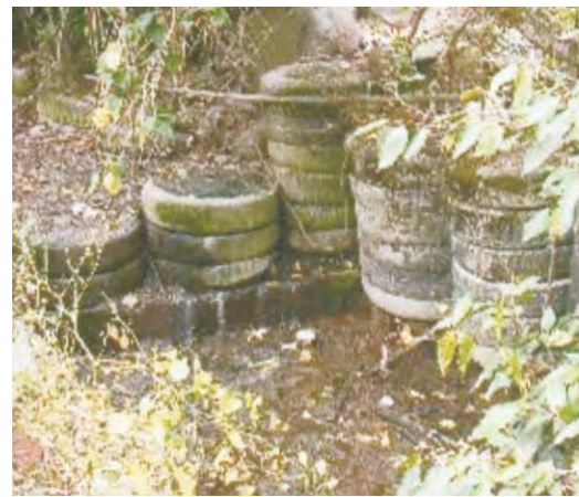
圖 4 廢輪胎蝕溝控制工程[6]
