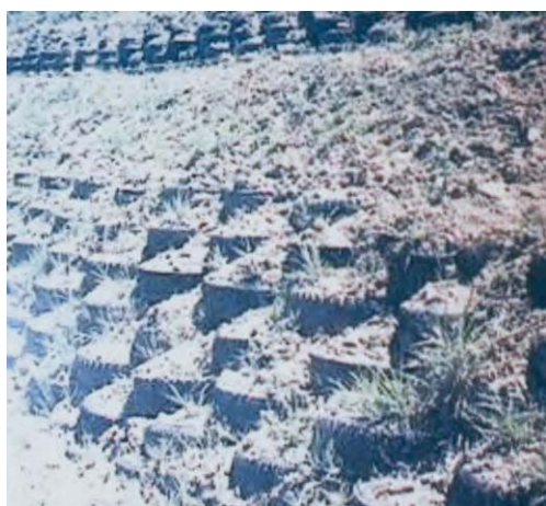
圖 5 廢輪胎邊坡穩定工程[6]
