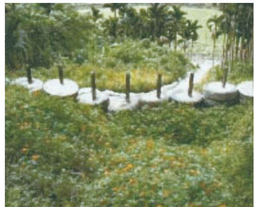
圖 8 鋼軌輪胎壩施工後[6]
