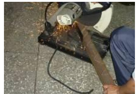
▲(圖十)切割機切割
