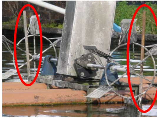
說明：固定水車的支柱
