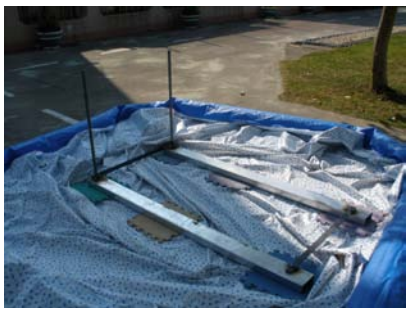
說明：底座組裝完成
