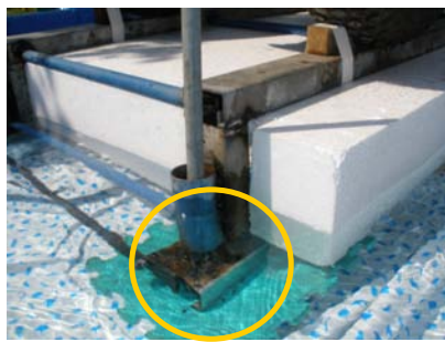
說明：車位剛浮起時，右側支柱與框架相對位置
