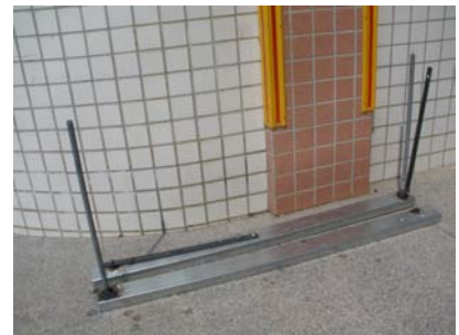
說明：新細管支柱完成
