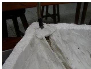
圖十三：利用油土將小水管固定
