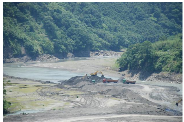
石門水庫集水區淤沙嚴重，怪手清淤情形。
