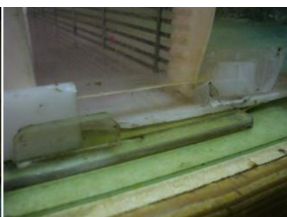
△圖十：開口恰可以一塊壓克力塑膠板擋住。
