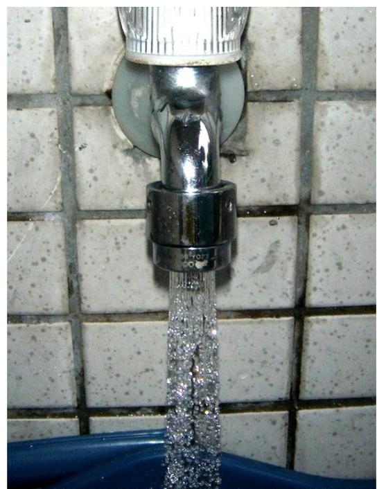
圖五：散孔式省水器材出水樣式
