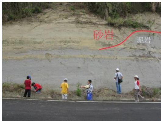
照片 15 二寮斜坡道中段砂岩與泥岩的不均勻沈積構造。
