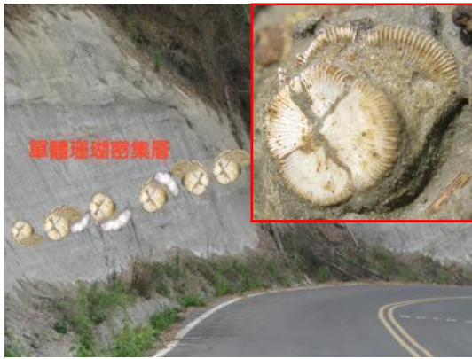
照片 27 二寮斜坡道離地面約 1.5 公尺的單體珊瑚密集層。
