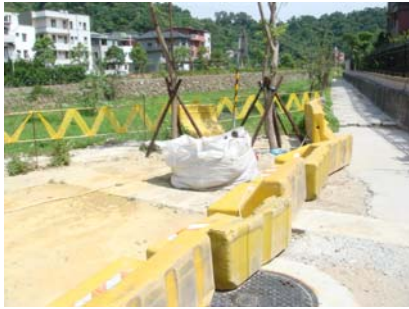
進行內溝溪景觀休閒段施工
