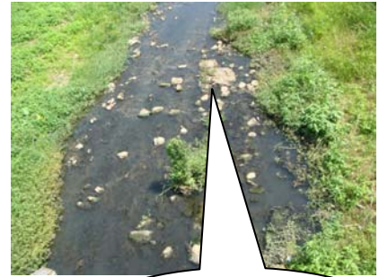
整治工程散落的 石塊破壞原本河
