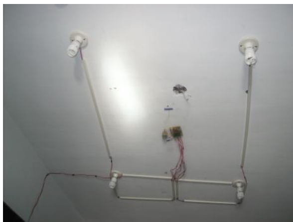
圖4-31 天花板電燈及自動控制系統安裝
