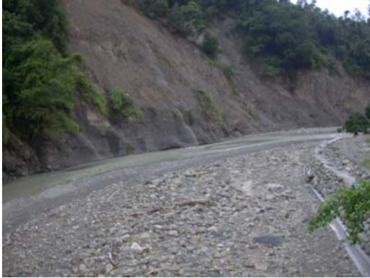
照片 1 甲仙鄉油礦溪沿岸新的崩塌
