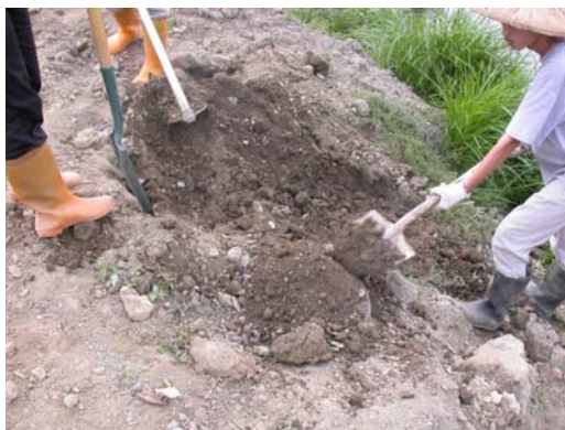
照片 15 手工挖鬆一個 32°斜坡
