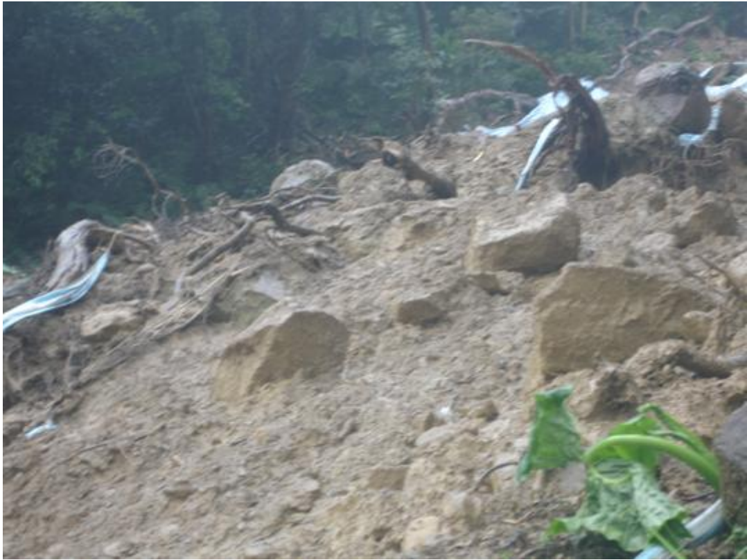
圖二十二 11月9日清晨下雨規模雖然變小，但是雨水仍然沖刷地表之土壤及岩塊，地表水混著土壤及岩塊，緩慢的向下移動。
