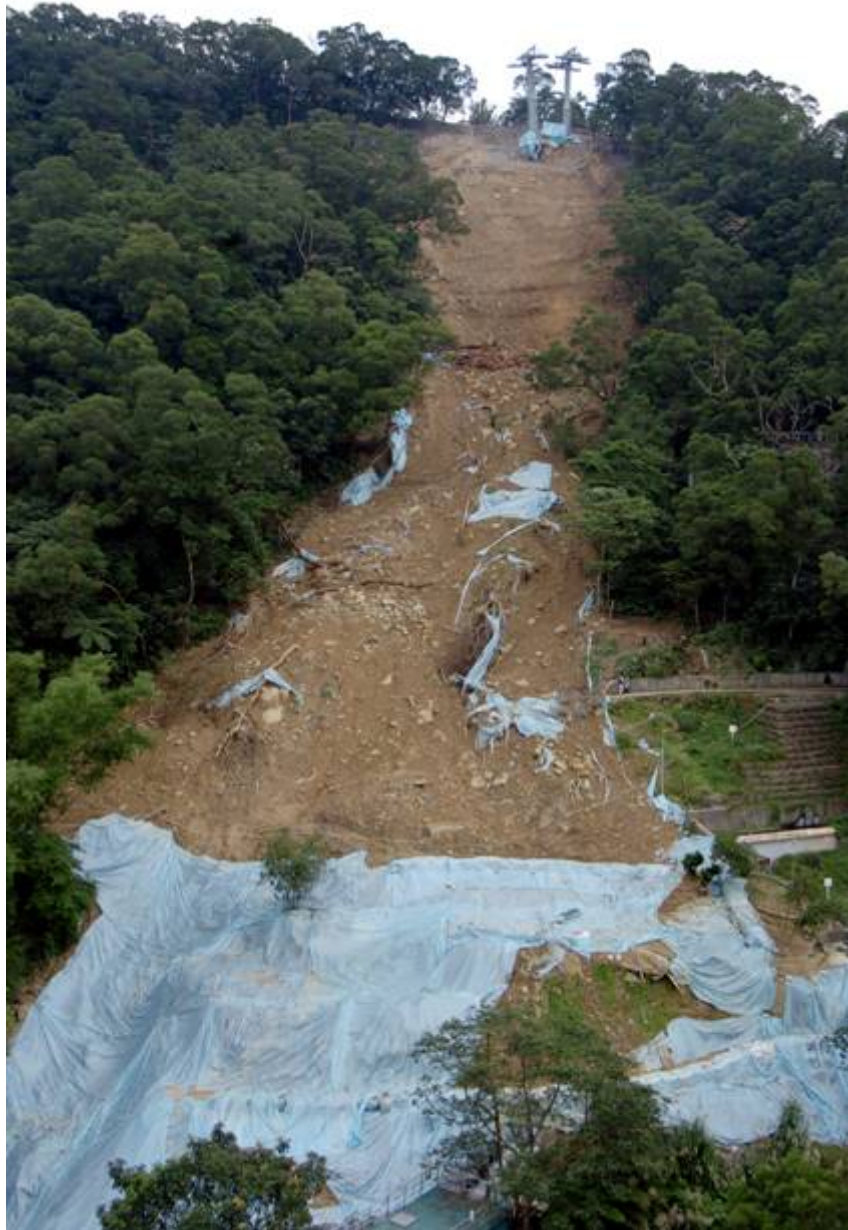
圖一 貓空纜車 T16 塔柱基礎臨近地區之邊坡受到大雨的沖刷產生地層滑動的現況。
