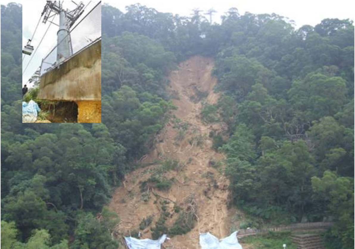
圖十四 薔蜜颱風後本區域出現初次地層滑動破壞，坡頂之 T16 塔柱則出現地表下陷現象，邊坡破壞尚未延伸至坡頂。
