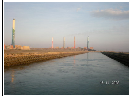
圖四 火力電廠出海口
