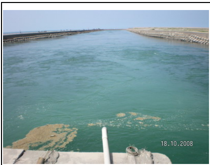
圖二 火力電廠出水口
