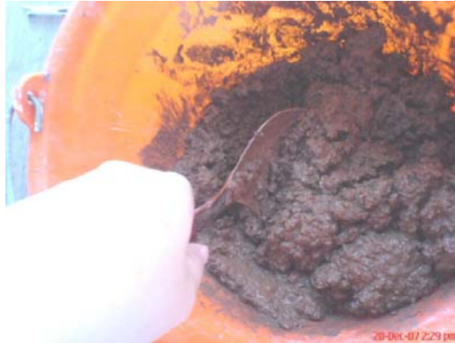
圖 5-30 拌合紅磚水泥砂漿
