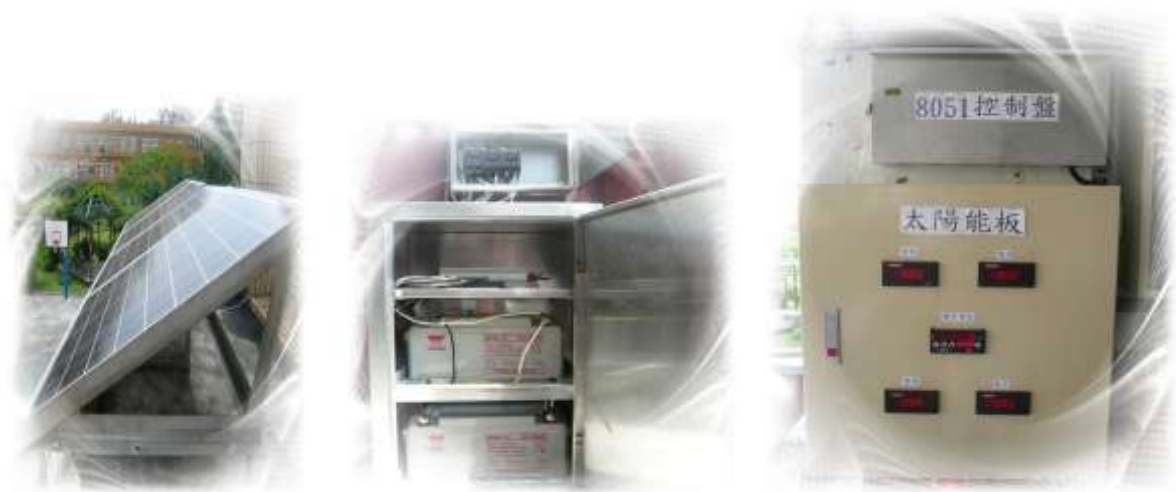
圖五電源系統架構
