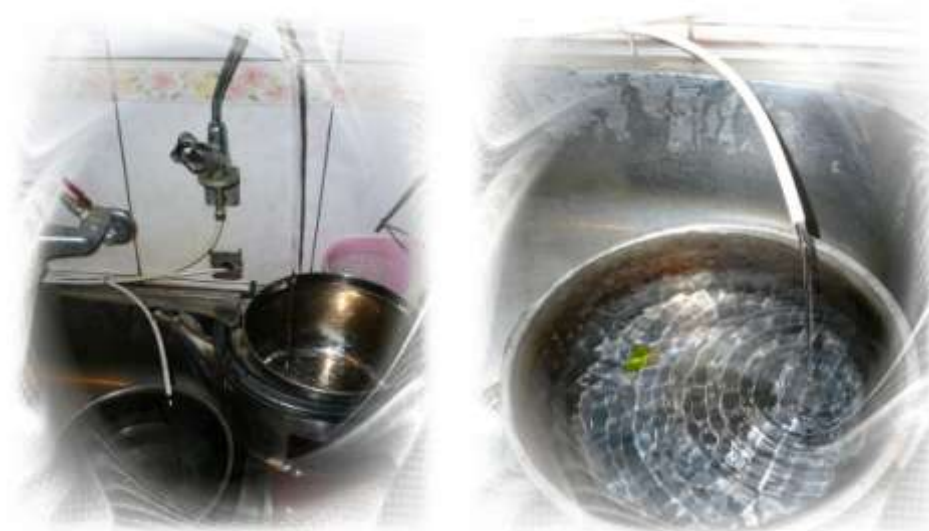
圖一 逆滲透過濾（RO）飲水機排放廢水
