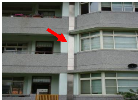
圖 48、校舍中間增設減震縫，內放保麗龍，可以達到防震的效果。
