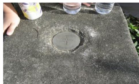
圖 40、衛星控制點外表像一個梯形柱，正上方則鑲著一塊金屬，上面有一個星星，星星四角的交會點就是中心。
