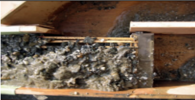
5-6 照片 一旦柵棒阻塞時，飛越現象很明顯，篩分功能喪失。
