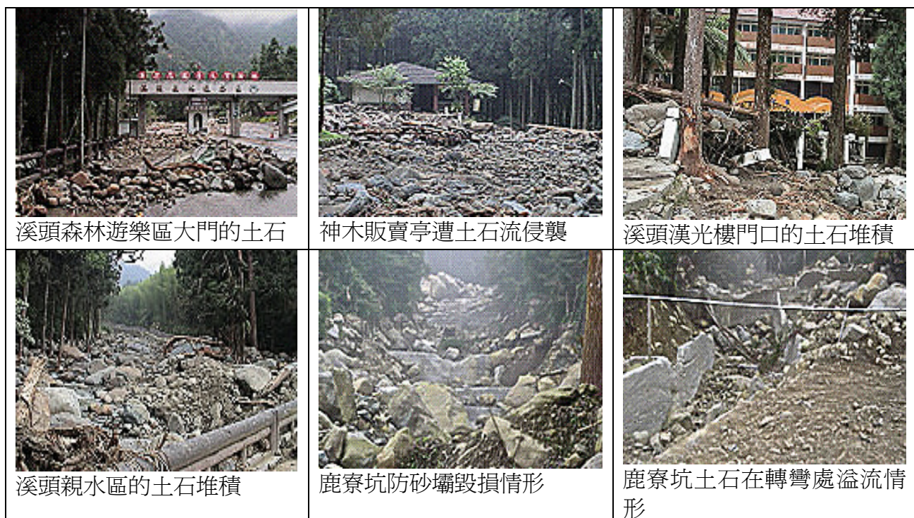
5-1 照片 台大實驗林溪頭森林區土石流破壞情形（照片由台大實驗林提供）
