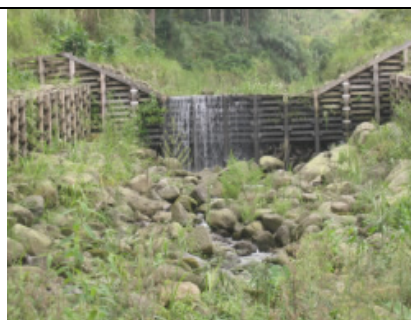
竹樁編柵正面照片
