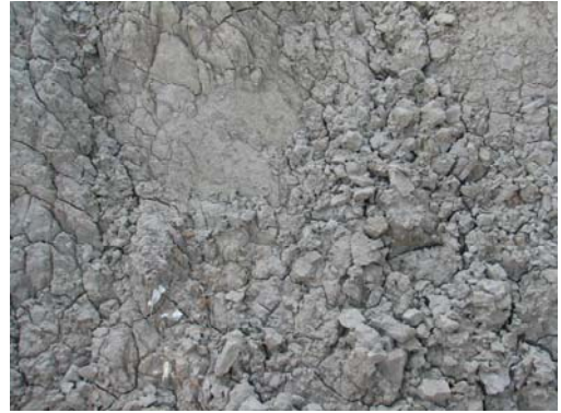
（照片六）乾季脊邊坡土指泥塊崩落的情形>
