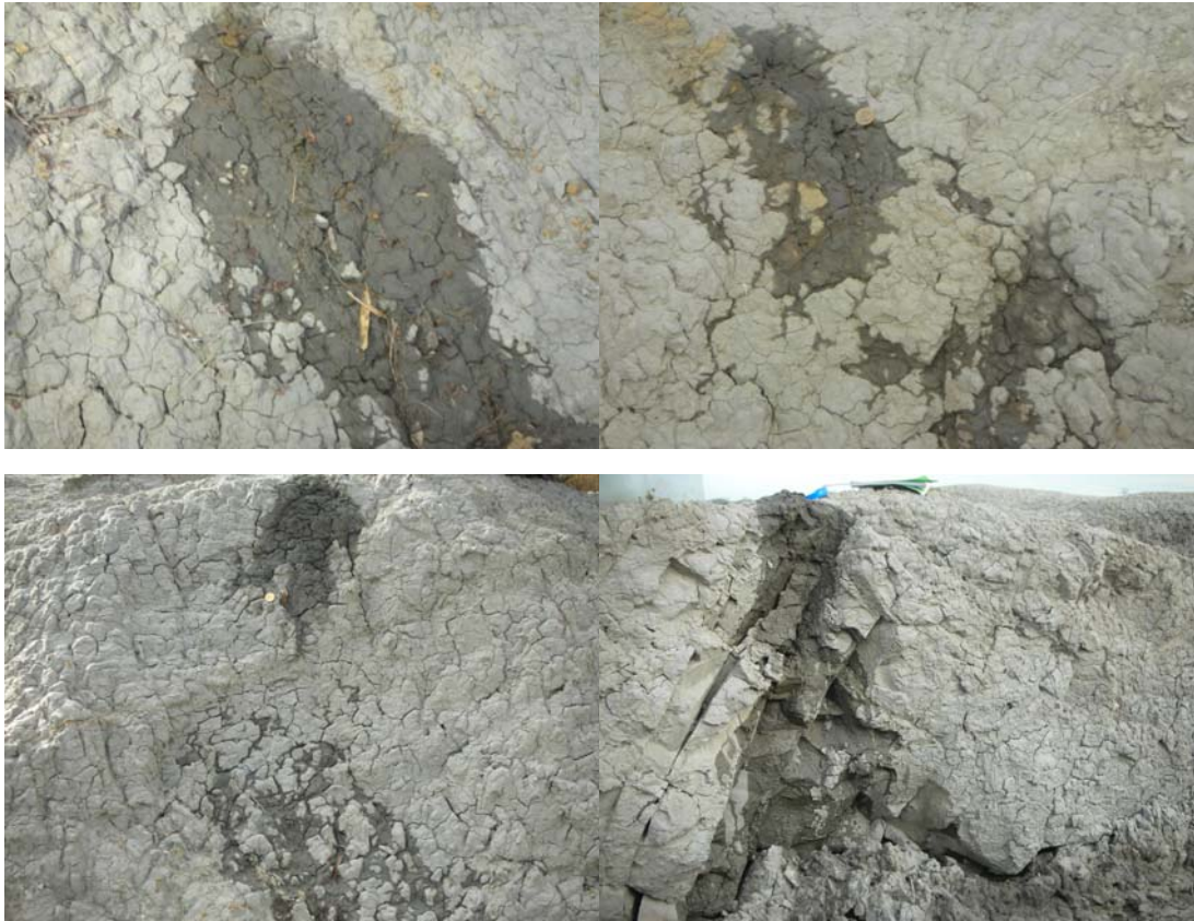
〈照片五〉脊邊坡角度沖水水流紀錄圖
