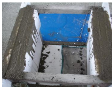
圖 2e 第二次垂直柱施作
