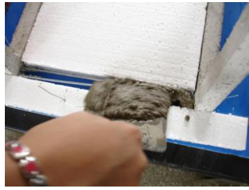
圖 2b 垂直柱施作(平置式)
