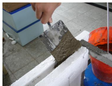
圖 2d 第二次垂直柱施作
