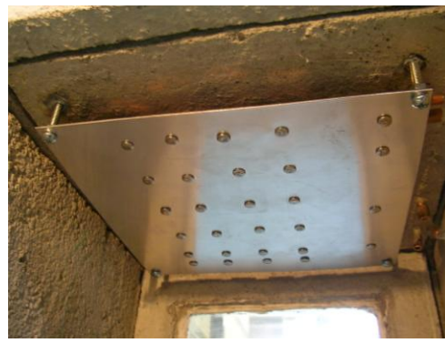
圖 6d 嵌頂式鋁製天花板完成圖
