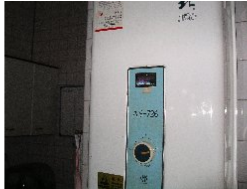
圖 9 通風室內點燃熱水器旁(B 區)
