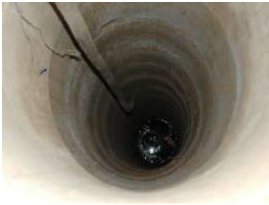
潛龍國小水泥式砌井有一丈多深
