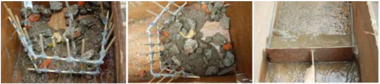
柵欄擋住大石頭和土沙 大量土石留在發生區 水及泥流到下游 圖 37. 打樁編柵阻擋土石流情形
