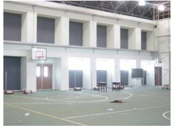
圖 4-12：裝設吸音板後的活動中心側邊
