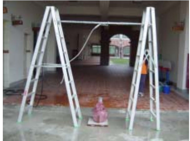
圖 5.4 整體設置完成
