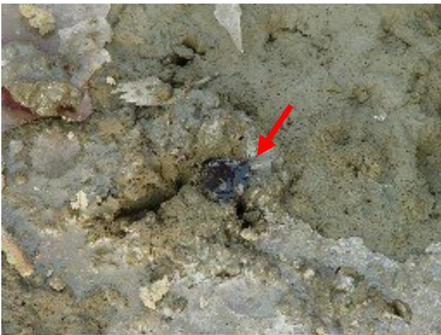
照片 2 洞穴凝固的聚合樹脂
