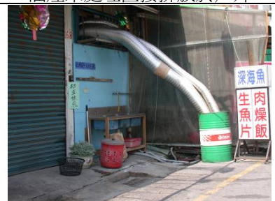
餐飲業油煙一般處理情形-1 油煙由導煙管排出
