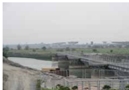
曹公圳整治工程
