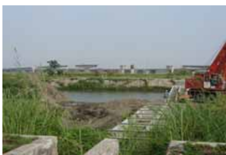
施工中的曹公圳
