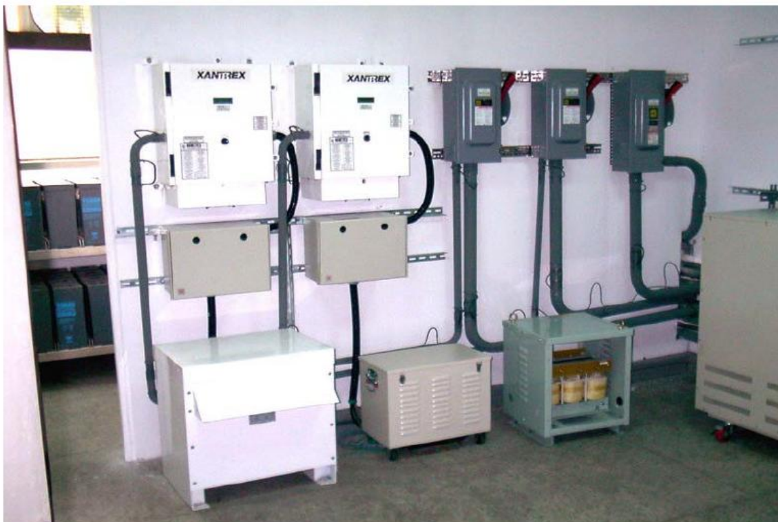
圖6：台電電力綜合研究所太陽能發電示範系統之一
