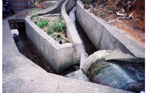
工廠及家庭廢水排入灌溉溝渠
