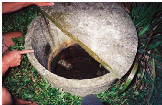
上圖的水井有排水管，水可流入灌溉溝渠
