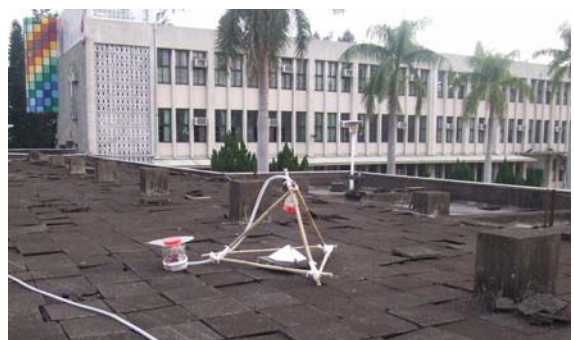
圖 15 東樓一樓樓頂
