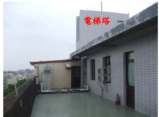
圖 12 行政大樓五樓樓頂
