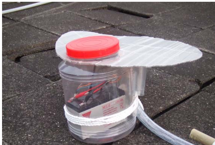
圖 11 蓄電池與訊號發射器
