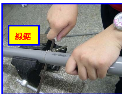
圖 17：鋸下適當長度的 PVC 水管
