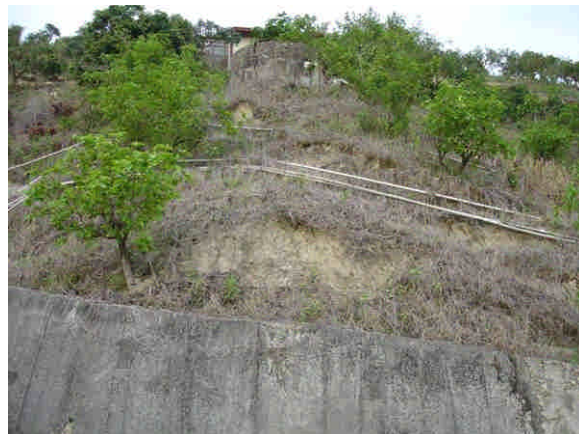
照片 15 地點：牛稠內最南側 順向坡上的泥岩已搖搖欲墜
