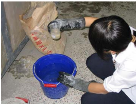
圖 8 量取水玻璃溶液所需用水量
