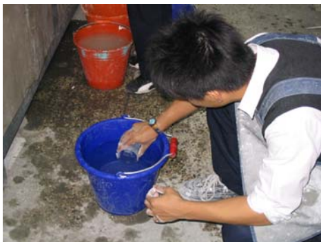
圖 6 量取水泥漿所需用水量
