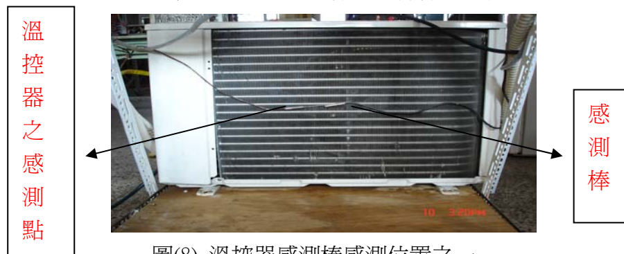
圖(8) 溫控器感測棒感測位置之一
